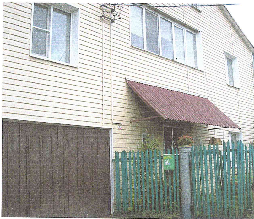
Вид дома № 31 по 1-ому проезду Марии Ульяновой с улицы.
