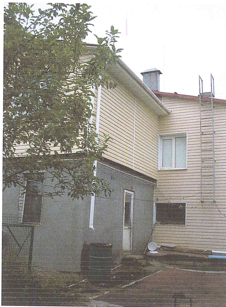
Вход в пристройку со двора (левая сторона строения).
